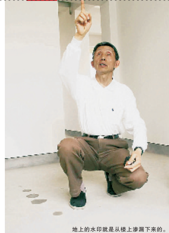
地上的水印就是从楼上渗漏下来的。
