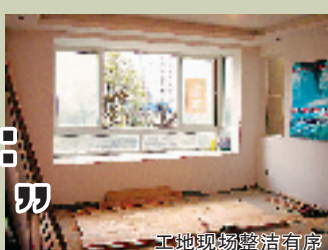
工地现场整洁有序
