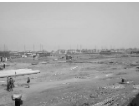
工地上,远处是农民房。
