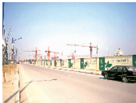
楼盘工地外墙
