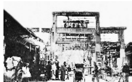
拆除武林门现场
