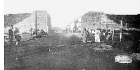
劈开城墙建马路的清泰门城墙
