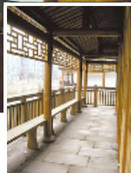
古街内的建筑
